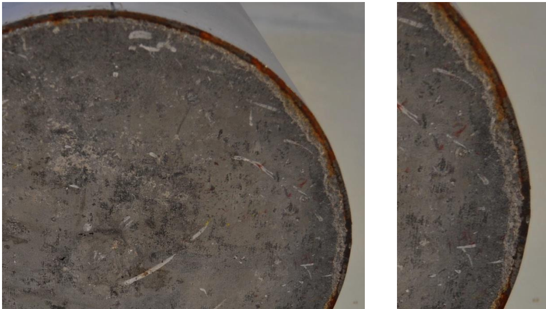
Σχήμα 4.2.8: Περιμετρική μικρο-αποφλοίωση του σκυροδέματος στη διεπιφάνεια με την κοίλη διατομή – λεπτομέρεια (δεξιά)
