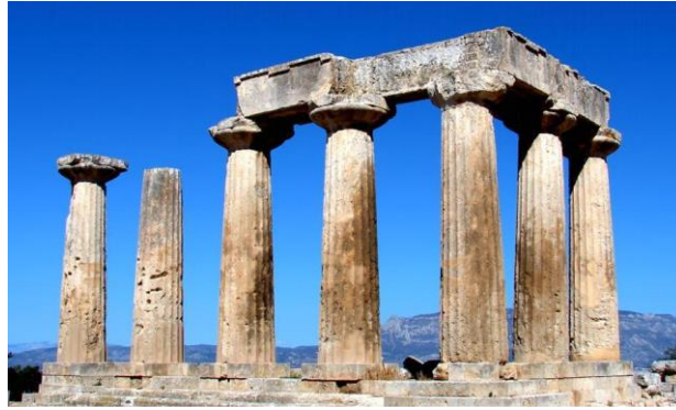
Σχήμα 2.1.3. Ναός του Απόλλωνα στην Κόρινθο. Οι μονολιθικοί, ελεύθερα εδραζόμενοι κίονες φέρουν ογκώδη επιστύλια και στέκονται σε μία περιοχή υψηλής επικινδυνότητας από το 540 π.Χ.
