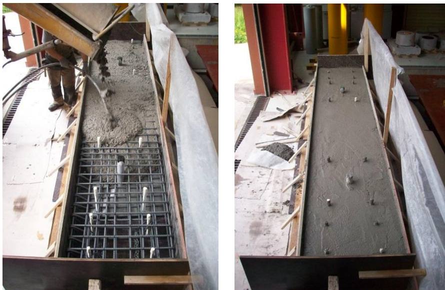
Σχήμα 2.4.3: Κατασκευή καταστρώματος γέφυρας κατά την φάση της σκυροδέτησης.
